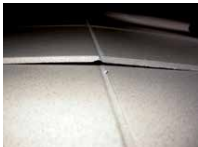
Figure 1 : Décollement et soulèvement des carreaux après une mise en service trop rapide du chauffage.
