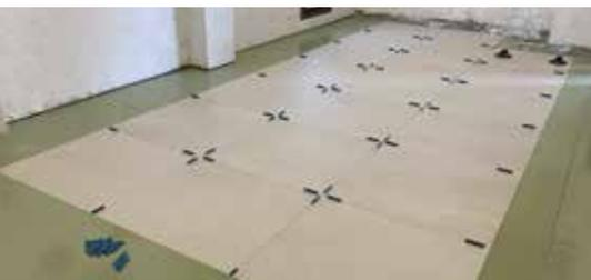
La pose débute par le déroulement d'un tapis de découplage fin et élastique (1,5 mm) en polyuréthane sur une surface plane et nettoyée. Les carrelages d'une largeur de joint de 2 à 3 mm y sont ensuite posés. La finition est réalisée au moyen d'un joint d'étanchéité élastique (à base de silanes modifiés) imperméable et qui renforce les carrelages les uns contre les autres.
