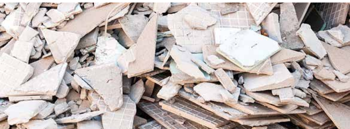
Figuur 1: De afbraak van een betegeling brengt een grote hoeveelheid afval met zich mee die zo goed mogelijk beheerd moet worden
