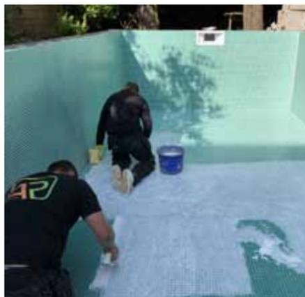
En ce qui concerne l'étanchéité elle-même, on optera de préférence pour un mortier d'étanchéité à base de ciment que l'on appliquera en plusieurs couches sur toutes les parois de la cuve. En plus d'offrir une bonne étanchéité, ces couches protègent aussi contre la migration du chlore, ce qui réduit le risque de corrosion des armatures du béton.
