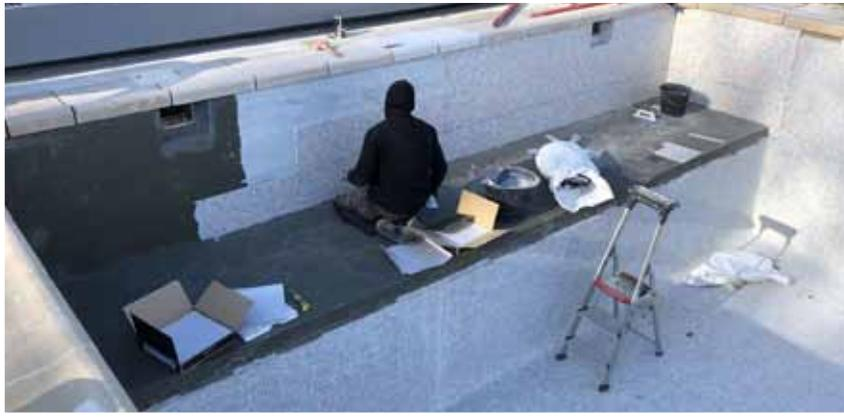
couche d'étanchéité à l'eau entre les parois en béton et le carrelage (voir NIT 247). Pour ce faire, on appliquera un enduit ou un mortier étanche à l'eau (voir figure 2 à la page suivante) sur l'ensemble des parois. La pose d'une natte de désolidarisation, telle que celle utilisée dans les parois carrelées des douches, est exclue, car la pression de l'eau est telle qu'elle n'offrira pas une étanchéité suffisante.
